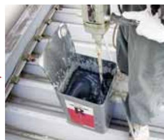
底部に沈殿していることがあるので、モーター攪拌機で十分に攪拌する
