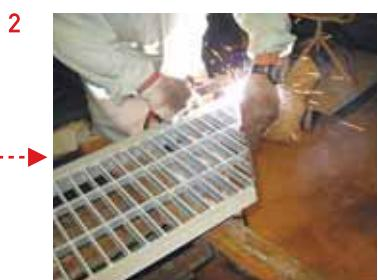
黒皮を除去したフラットバーを切断面に溶接
