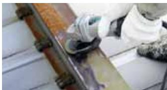
プラスチックまたは動力工具を使用して、水分・油分・黒皮・さび・旧塗膜を除去し、清潔な金属面を露出させます。
