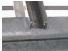
ZAM鋼板の端面補修
