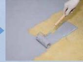
表層の凸部を研磨し、平滑にした後、タフシール#50に各種トナーを5%添加したものに硬化剤を混合し、塗りムラがないように均一に塗布してください。
